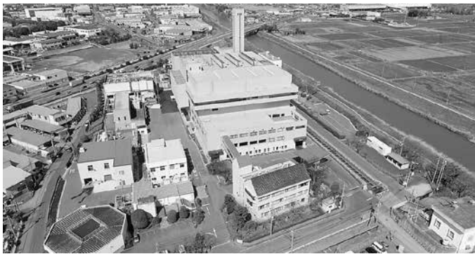
豊野環境衛生センター
