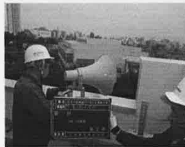
スピーカー機器の設置
