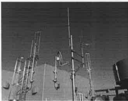
市立医療センターへのアンテナの設置
