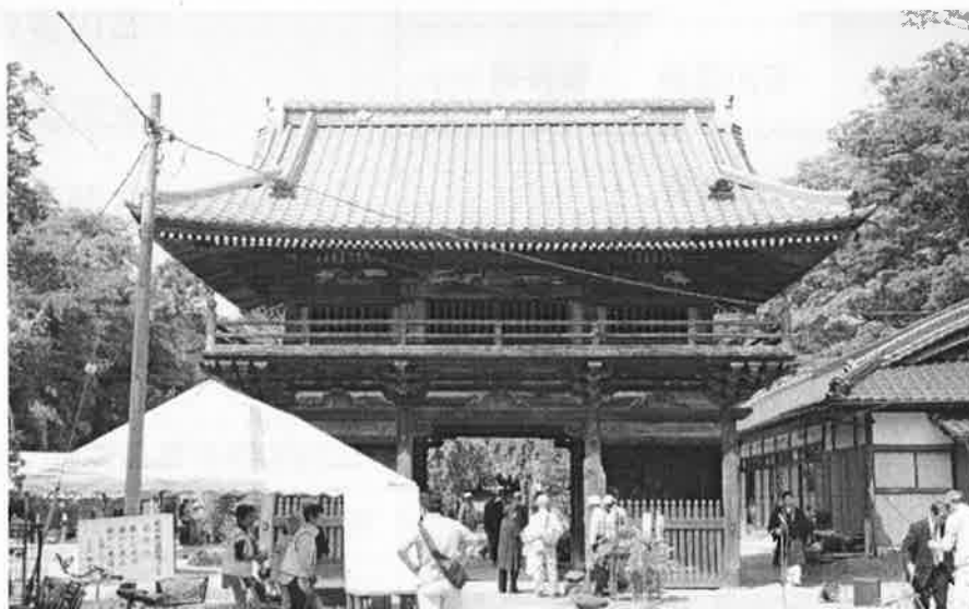
半解体の修理を終えた 小湊観音院仁王門
