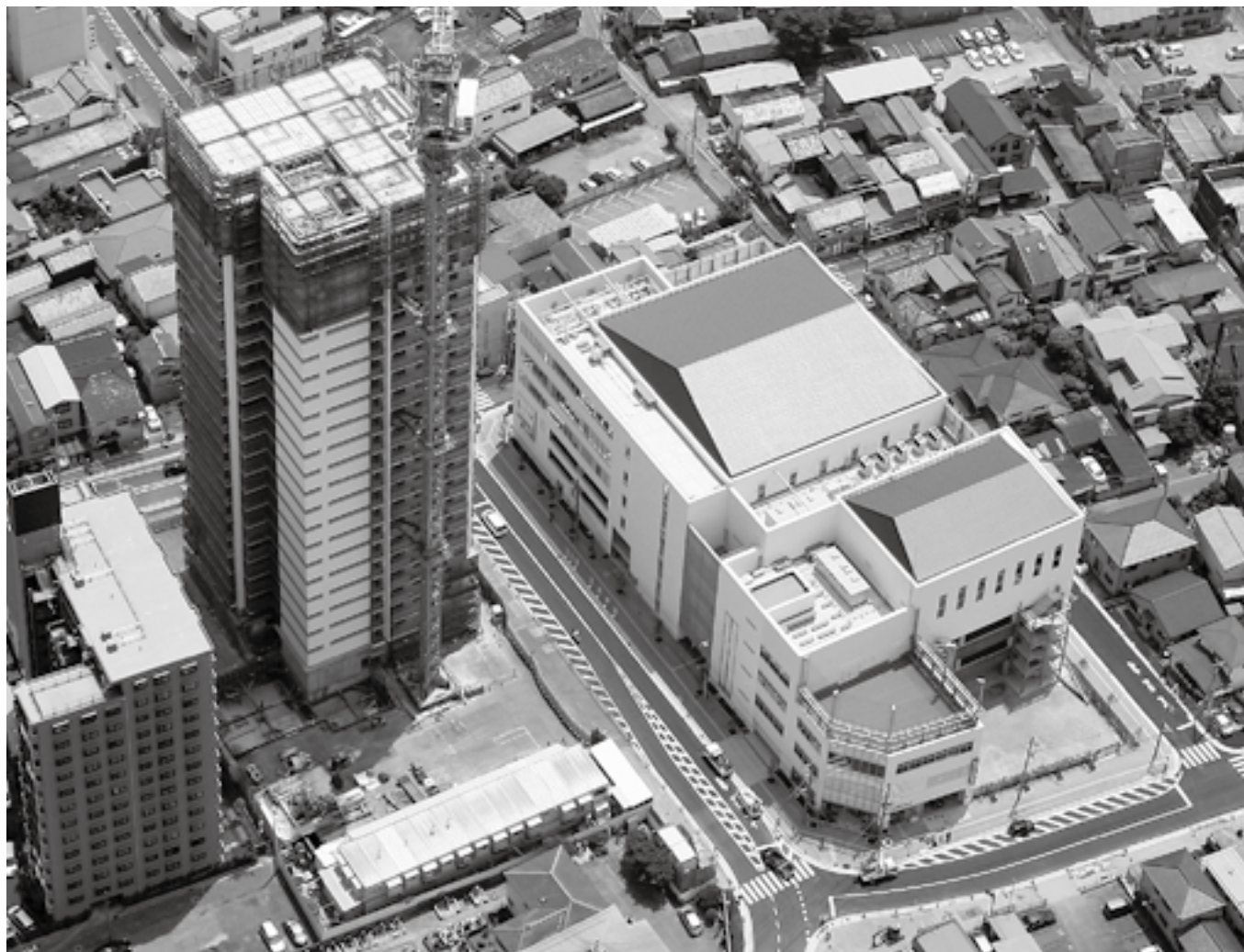
粕壁三丁目A街区再開発事業地
