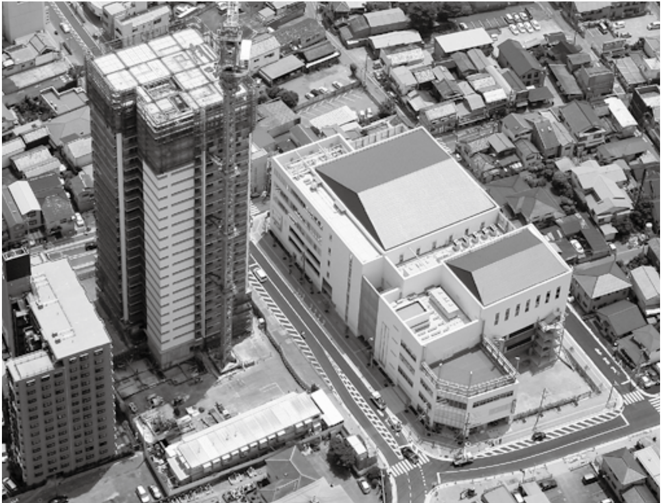
粕壁三丁目A街区再開発事業地
